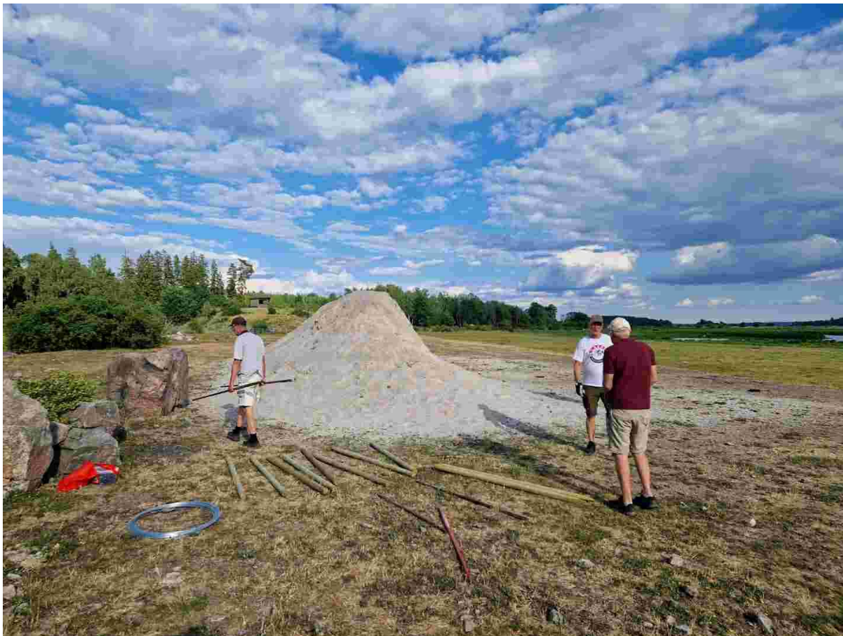
Tisdag 27 juni – Uppsättning av staket runt Backsvalehögen i Norsa
